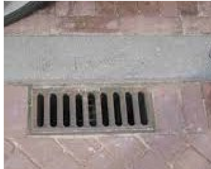
Smalle straatkolk bij terras 20x45 cm rijloper Marktplein Lijnkolk type ACO Multipoint K200 voorzien van retro rooster (Leverancier: Aco o.g.)
