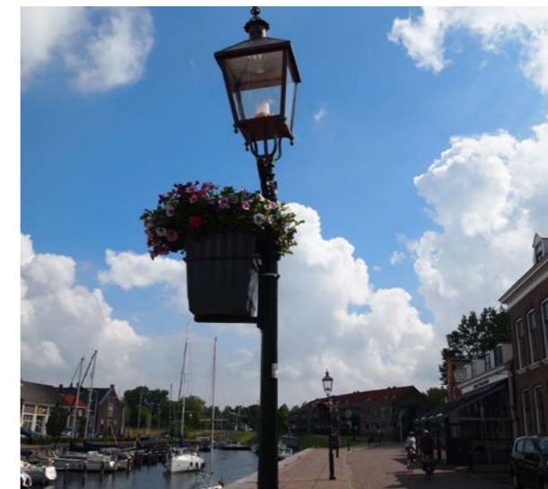
Historische paaltop hergebruik bestaande masten, opnieuw lakken in kleur standgroen RAL 6009 en nieuwe masten toevoegen gelijk aan bestaand
